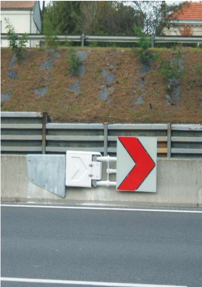
Systeme de signalisation pour voie d'autoroute « condamnée » en cas d'accidents ou de travaux. Un vérin LA36 de Linak commandé électroniquement à distance (protégé par la coque blanche) déploie ou rétracte la barrière.
