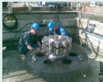
Montage des groupes de commandes des mécanismes d'actionnement des portes des écluses d'EDF
