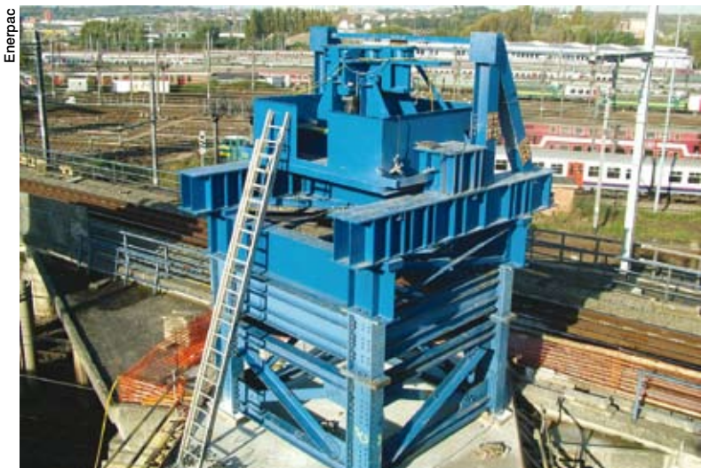
Des piliers en acier soutiennent le pont pendant son déplacement.
