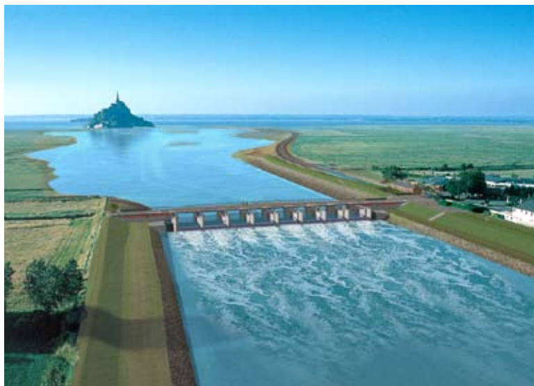
Le système de vannes du barrage permettra de recréer l'estuaire du canal du Couesnon et de reconstituer progressivement un paysage de grèves. (Photos : Syndicat Mixte Baie du Mont-Saint-Michel, Daniel FONDIMARE et IMAGENCE 3D / MG DESIGN)
