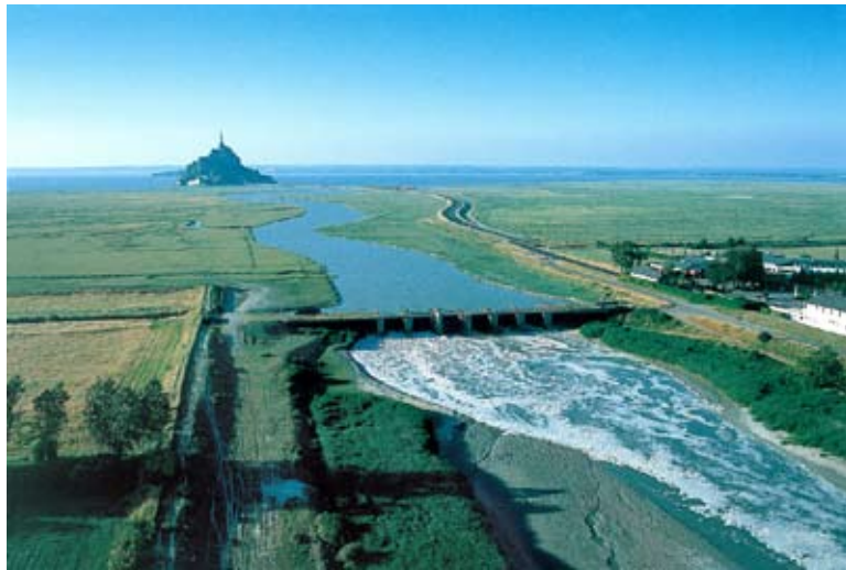
Le système de vannes du barrage permettra de recréer l'estuaire du canal du Couesnon et de reconstituer progressivement un paysage de grèves. (Photos : Syndicat Mixte Baie du Mont-Saint-Michel, Daniel FONDIMARE et IMAGENCE 3D / MG DESIGN)
